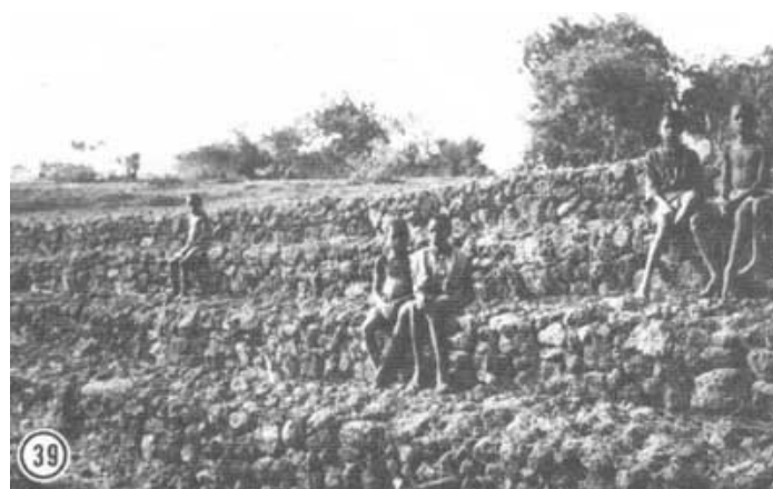
Photo 39: Le micro-barrage que l'on voit sur la photo 39 a une largeur de 4 mètres à la base (2 longueurs de gabions) et d'un mètre au sommet (1 largeur).
