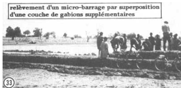
Photo 33: relèvement d'un micro-barrage par superposition d'une couche de gabions supplémentaires
