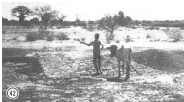
Photo 42: micro-barrage en forme de radier, permettant le passage des véhicules. Les bords sont faits de gabions; le centre est fait de cailloux et de pierres plates.
