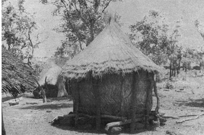
Figure III.4 Grenier aéré en chaume (Burkina Faso)
