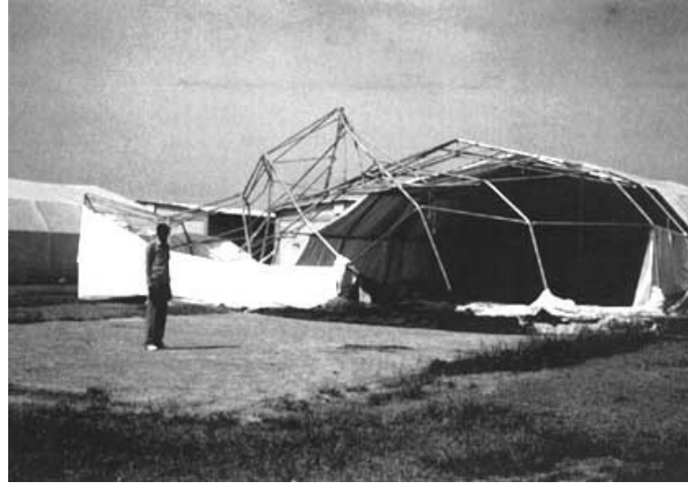
Cliché 12. Défaillance d' un bâtiment revêtu de plastique à cause de la force du vent. Mali
