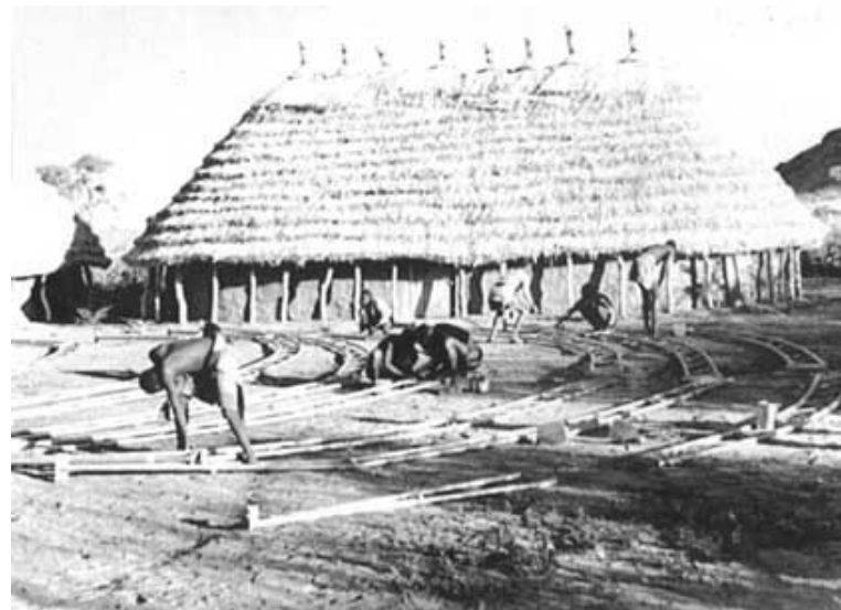
Cliché 7. Montage d'éléments par de la main-d'oeuvre locale non qualifiée
