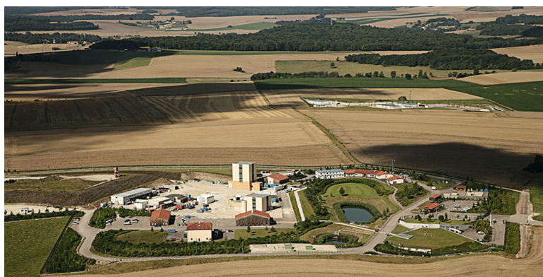
Le laboratoire de recherche souterrain de Meuse/Haute-Marne.
