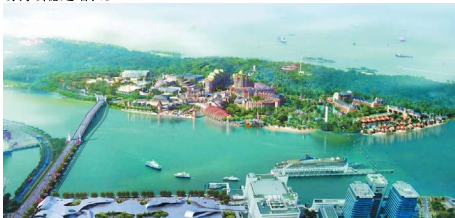
北京京冶工程有限公司承建的圣淘沙综合娱乐设施项目（部分）
