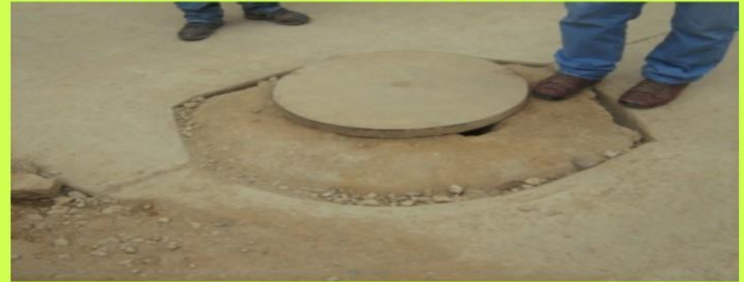
PROGRESIÓN 0+050 DEL JR. PIURA
