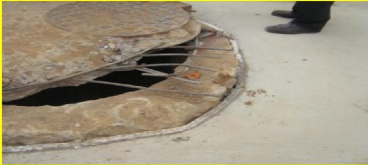
PROGRESIÓN 0+885 DEL JR. AYACUCHO
