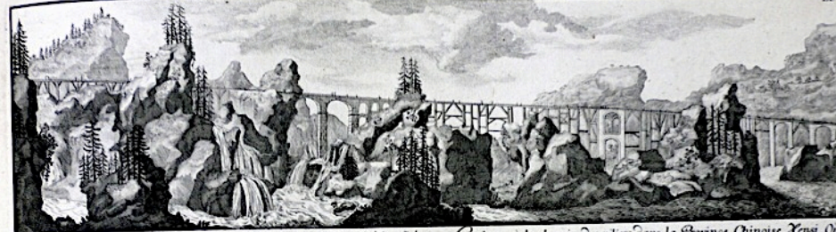
Cientao, oder der Weg der Säulen in der Sinesischen Provinz Kensi. Wo über Berg und Thal fünf oder sechsen Säulen an die Dampffahrt zu führen, sind 30 Säulen lauge angelegt worden. Welche theils auf Däcken rühret, theils auf steinernen Säulen ruhen, so nemlich die Däcker wieder voneinander löst. Die Höhe ist an einigen Orten so abstrichlich daß sie ein Strahlen machen müß. Die Länge ist 1000 Schritt, die Breite 10 Schritt, die Höhe 10 Schritt. Cientao, ou le chemin des piliers dans la Province Chinoise Kensi. On a joint les hauts des montagnes par un pont de 30 piliers pour servir à la circulation en allant de la Capitale à Canton. Les piliers sont de pierre de taille, et sont plus ou moins élevés, les uns sur des piliers de pierre, les autres sur des piliers de bois. La longueur de ce pont est de 1000 pas, la largeur de 10 pas, et la hauteur de 10 pas.
