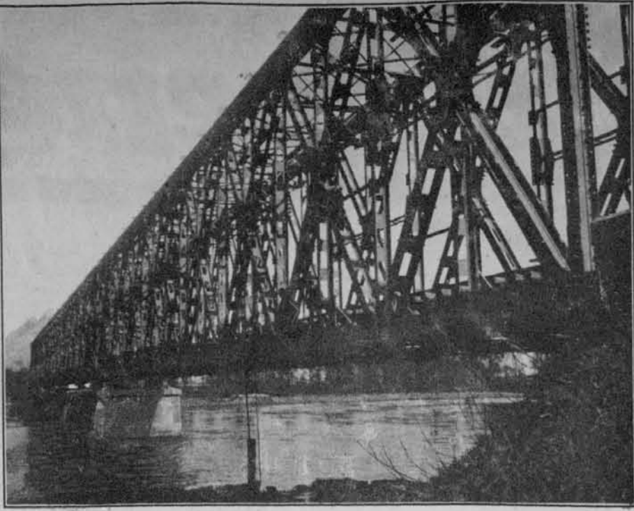
Novi železniški most čez Muro pri Veržeju. (Fotografiral F. I.)
