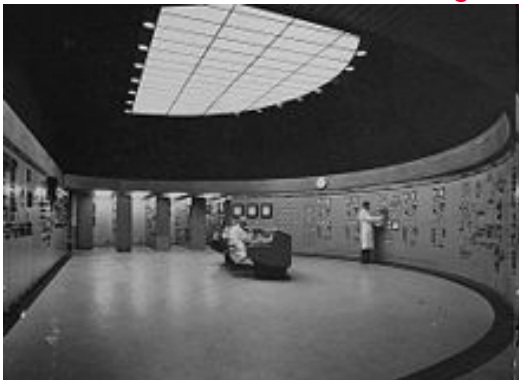
Sala de controle do reator de Agesta
