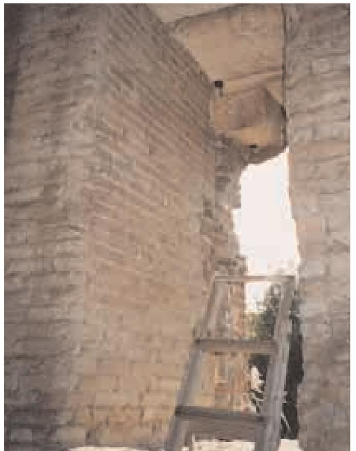
*Nella foto sopra un particolare dell'arco cieco, posto sopra la porta finestra, che mette in risalto gradevoli decorazioni in cotto. Nella foto a fianco la porta finestra vista dall'interno, da cui si può rilevare il consistente spessore del muro (metri 2,30).*
