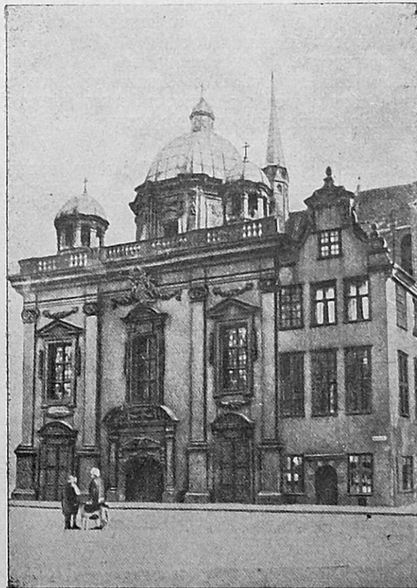
Kaplica Królewska, zbudowana przez Jana Sobieskiego w 1681 r.
