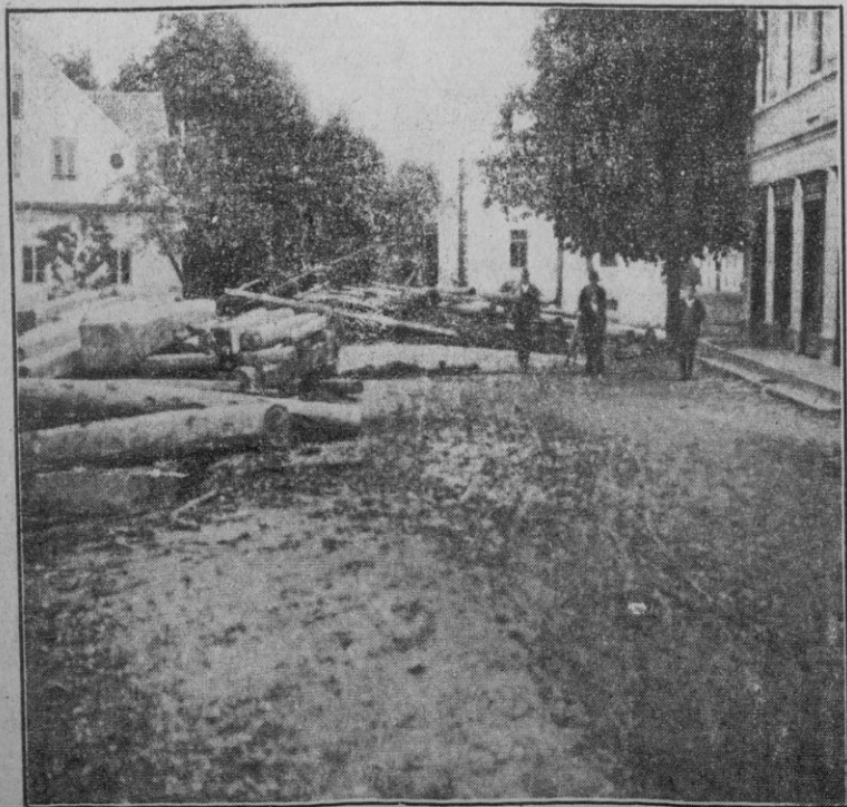
Naplavljeni trami na cesti v Stari vasi pri Žireh.
