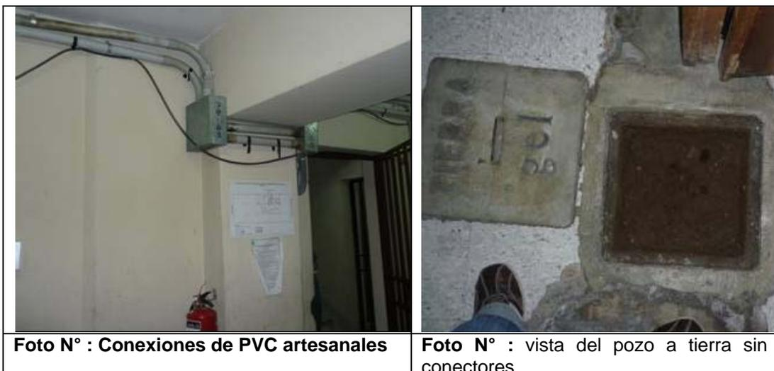
Foto N° : Conexiones de PVC artesanales
