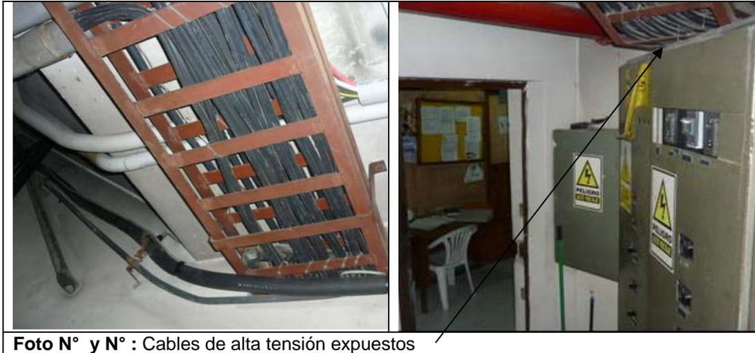
Foto N° y N° : Cables de alta tensión expuestos
