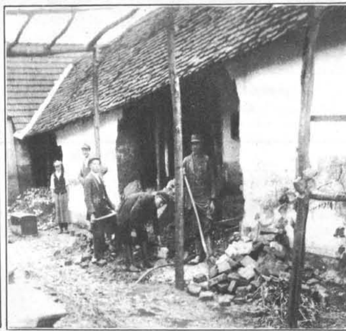
Bratkovičeva hiša v Cvetni ulici po povodnji.
