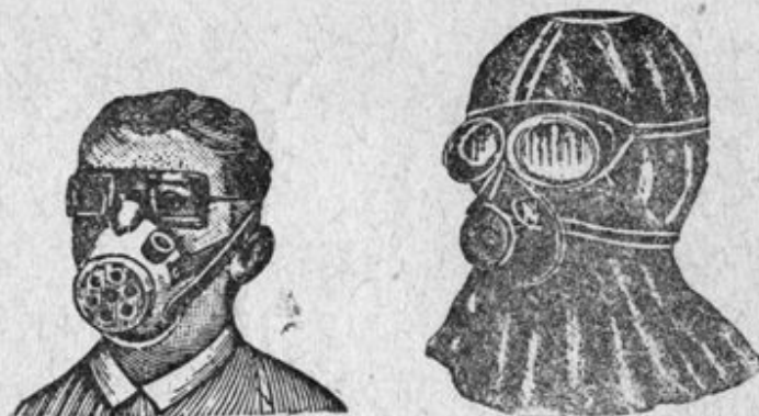
Фиг. 6. Промышленные противопопыльные маски 1914—15 гг. со вставным цилиндром и клапаном (по Аркадьеву).
