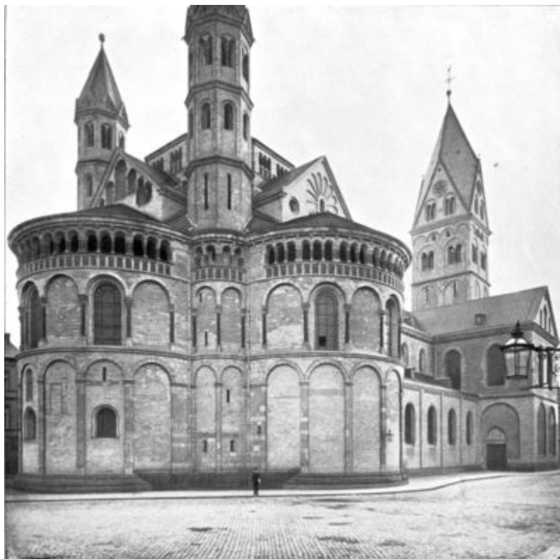
Fig. 3. St. Apostelkirche, Ansicht der Nordseite. Nach einer Aufnahme der Kgl. Messbildanstalt.
