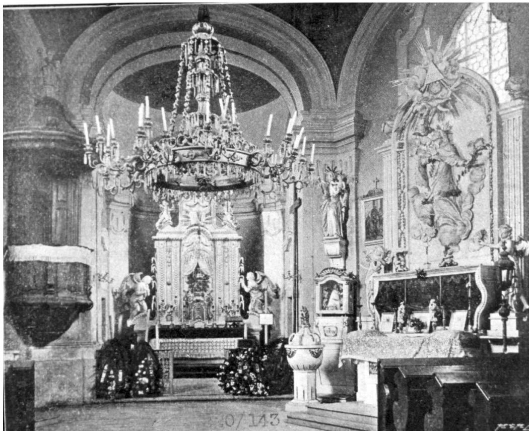
Snímek 220/143 Kostel ve Štáhlavech, vnitřek ↓
