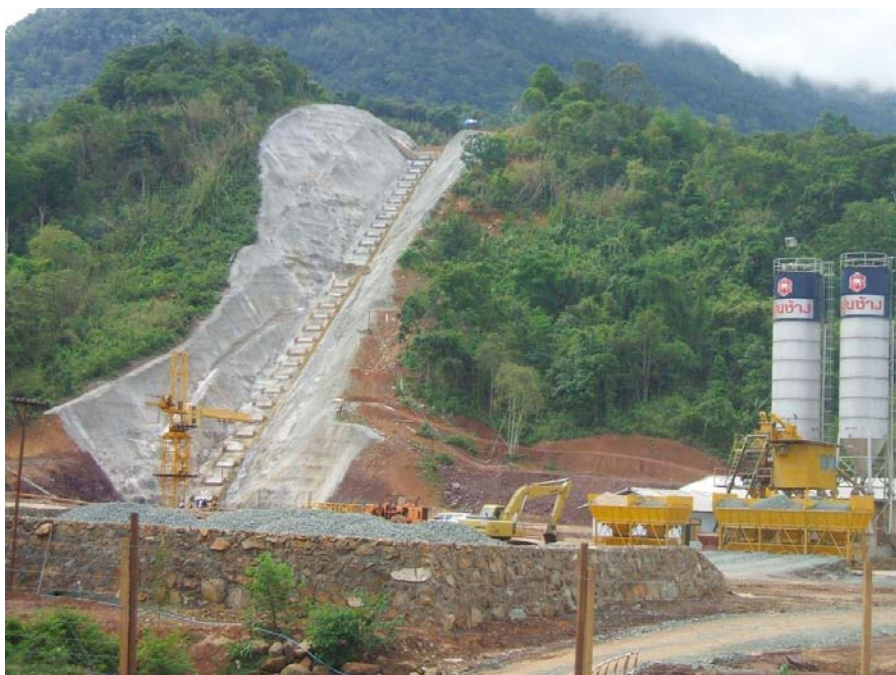
中国最大承包项目——XESET2——压力钢管施工
