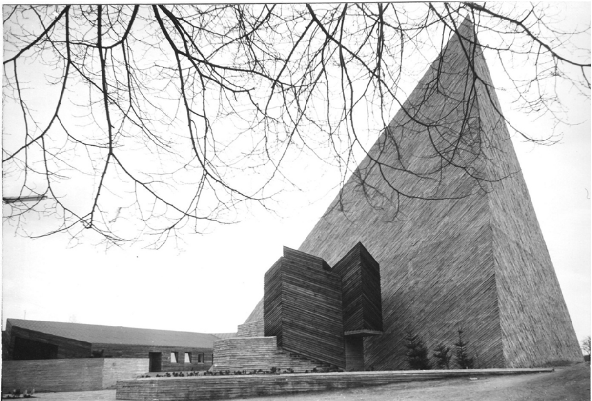
Auferstehungskirche und Gemeindezentrum Köln Buchforst 1968
