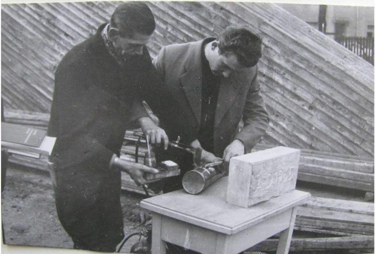
Verlöten der Kasette für den Grundstein
