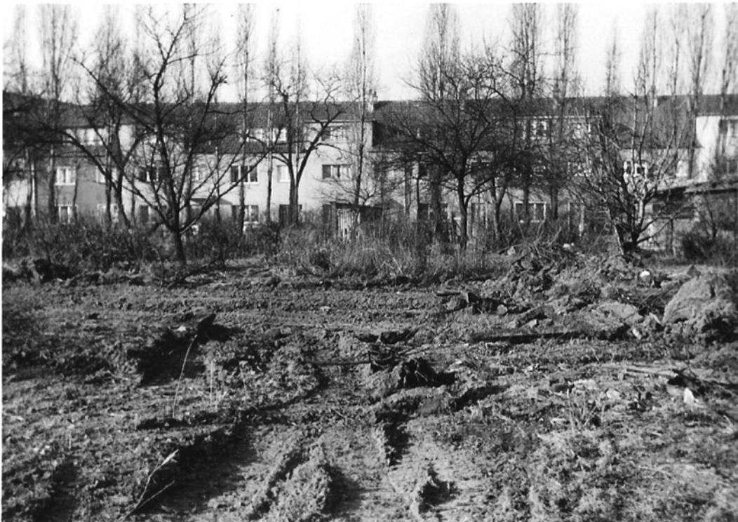
Entrümmern des Grundstücks an der Kopernikusstr., Zustand 16.1.1964
