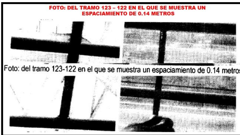
El detalle de la baranda del plano DA-02 y su posterior construcción que permite que permiten el paso de una esfera mayores a 0.13 metros, no se ajusta a lo señalado en el Reglamento Nacional de Edificaciones que en el título 111.1 Arquitectura, Norma
