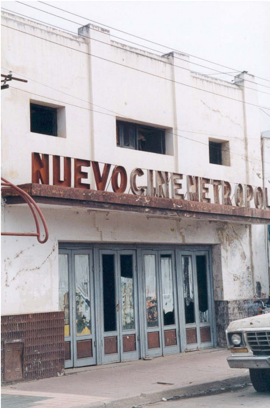
Cine Metropol. Antes de su demolición.
