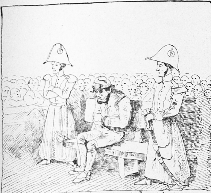
Secourtebandier ayant été arrêté est jugé par la Cour d'Assises.
