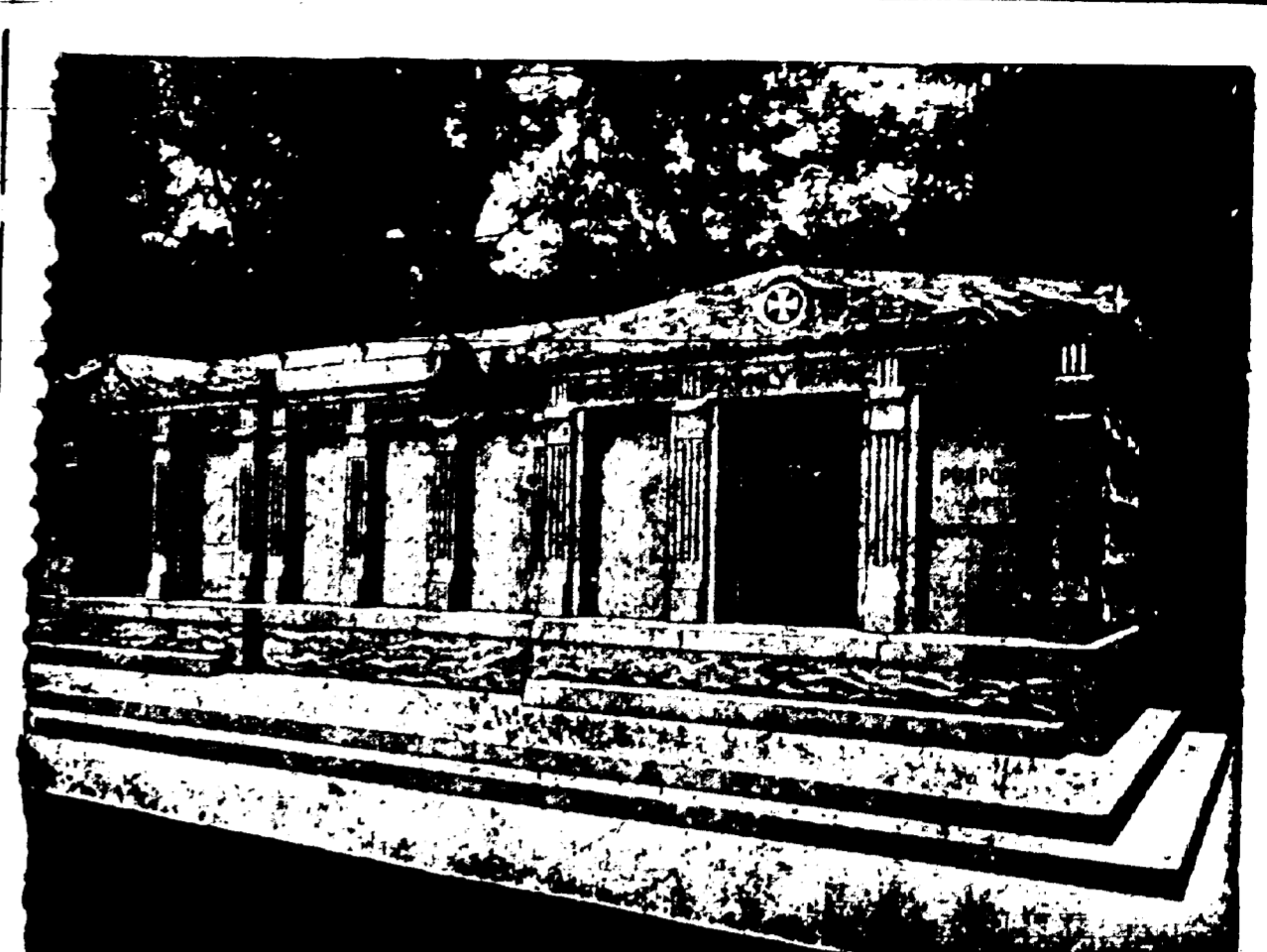
A VENDRE - Les caveaux dont on voit ci-dessus la gravure. Ils sont en granit, au cimetière St-Louis No 3, Avenue de l'Esplanade. Il en est qui ont une contenance de 12 grands cercueils et d'autres de 6. Chacun est distinct des autres, et tous seront vendus séparément à des prix très réduits. S'adresser à CHAS. A. ORLEANS, No 319 Rue Carondelet ou au Gardien.
