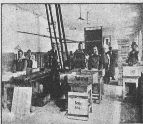
Avtomatične stiskalnice za vtisnjevanje imena »ZLATOROG« in tovarniške znamke v milo.
