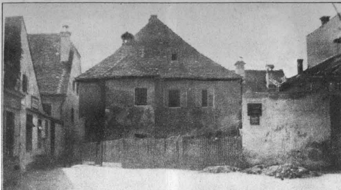
Hiša grofa Tattenbacha v Ključavničarski ulici, kjer so sedaj policijski in odgonski zapori.
