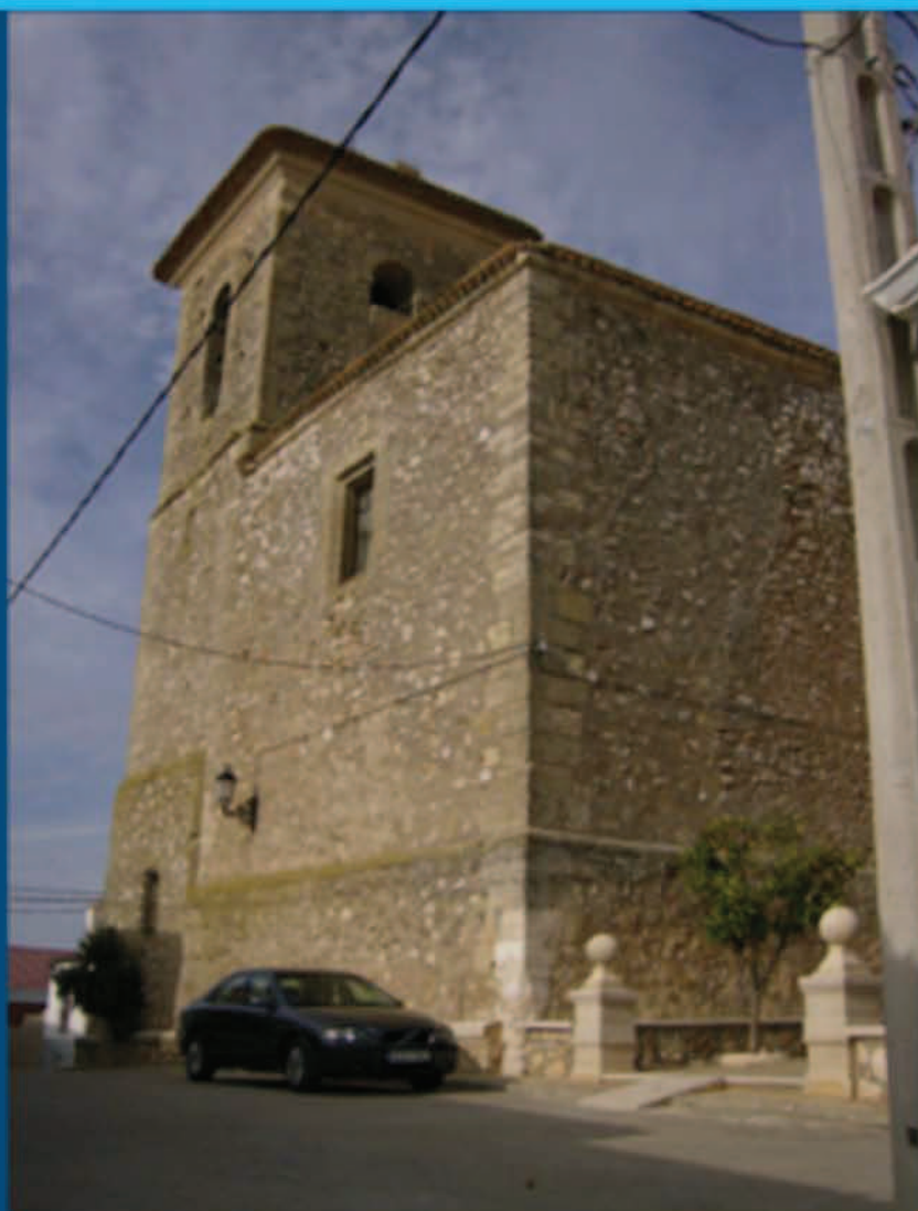
Fachada sur-oeste de la Iglesia de Pinarejo en la que se observa la torre de tres cuerpos
