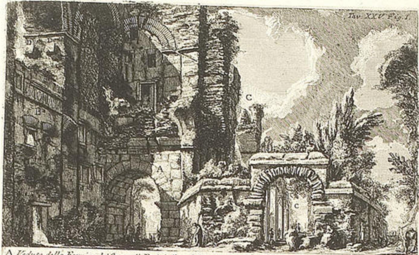
A Veduta della Fornice de' Consoli Dolabella, e Silano investita dagli archi Neroniani provenienti dal Condotto dell'Acqua Claudia. B Avanzo della Iscrizione di Nerone ne' suoi archi. C Prosecuzione degli stessi archi. D Modelli di travertino serviti all'elevazione della fabbrica, e lasciati per i fortuiti risarcimenti. Piranesi Architt. dis. inc.
