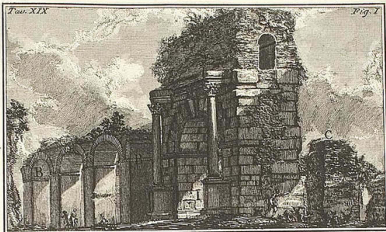
Monumento del Condotto Antoniniano, sotto al di cui arco passava la Via Appia. A. Speco, o sia canale del Condotto. B. Opera arcuata del medesimo. C. Avanzi della stessa opera.
