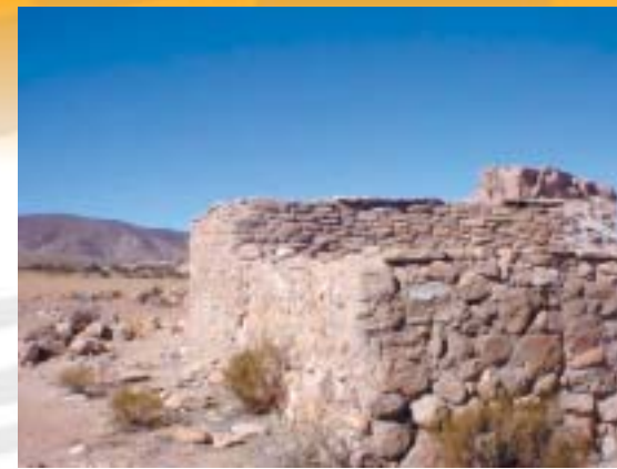
Reconstrucción de parte del Tambo Inka de Zpahuira, Comuna de Putre.
