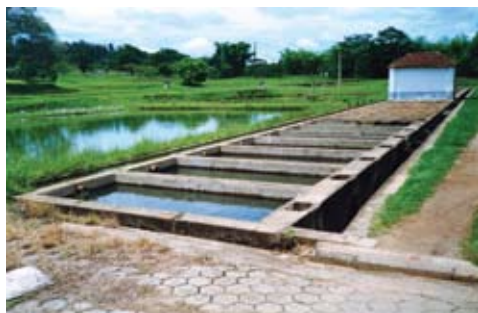
Estanques de concreto para crecimiento de juveniles
