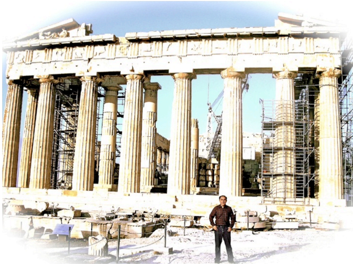
Reconstrucción de las bases y pilares del Partenón, considerado como el más hermoso de los edificios clásicos y arquetipo emblemático de la arquitectura. Obra de Fidias en honor a Atenea, en la Acrópolis griega (del siglo de Pericles).
