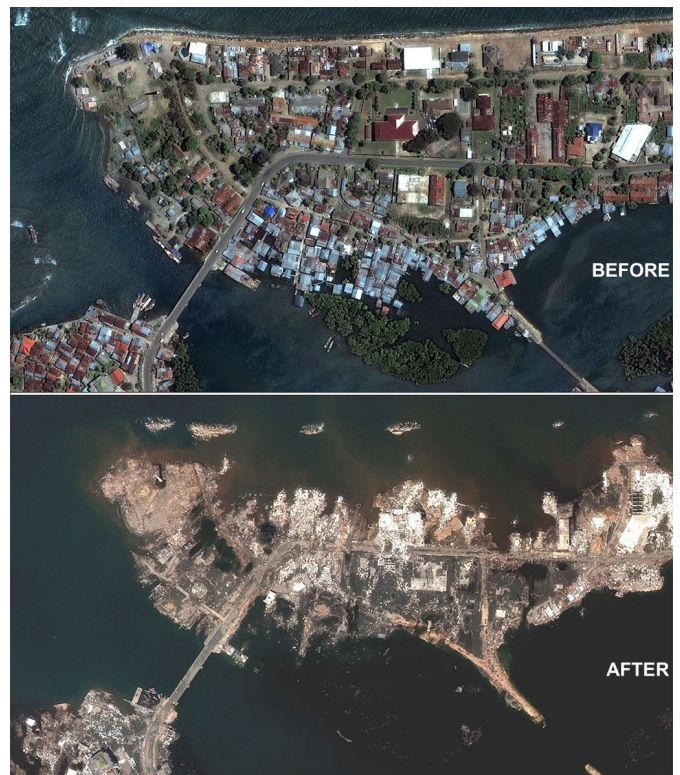
Abbildung 2 - Ortsteil von Banda Aceh, der Provinzhauptstadt von Aceh mit 150.000 Einwohnern auf Sumatra (Indonesien), vor und nach dem Tsunami. Fotos von digitalglobe.com
