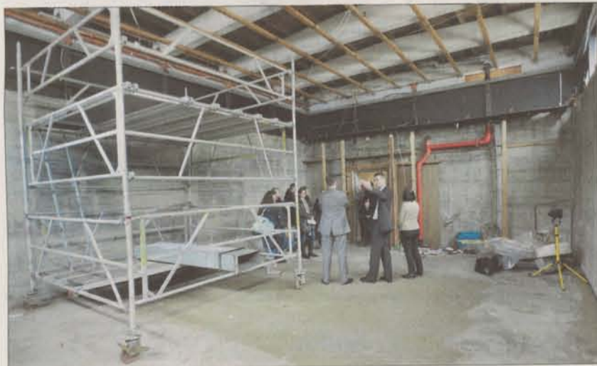
Derzeit sind die Umbauarbeiten im ehemaligen Kino-Saal des Dürer-Hauses im vollen Gange. Hier sollen ab 26. Juli bis zu 25 Dürer-Kopien zu sehen sein.
