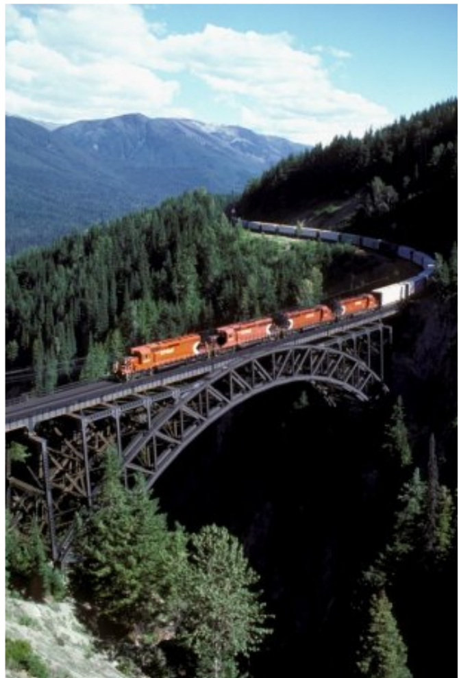
Ein in Richtung Osten fahrender Güterzug auf der Stony Creek Bridge in der Nähe des Rogers Pass
